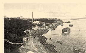
1906 Строительство и начало работы первой электростанции в Хабаровске (120 кВт)
